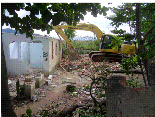
Foto 1: casas sendo demolidas. Marco Malagoli, 2013. Acervo NESA
