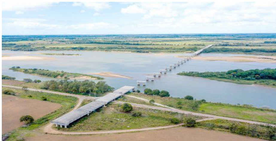
Imagem 9 – Foto recente das obras da ponte Fonte: Fotografia Michel Filho, jornal online Terceira Via, 27 de agosto de 2022. 12
