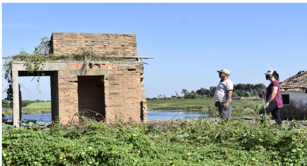
Imagem 52 – Estruturas do banheiro e caixa d'água. Fonte: Arquivo pessoal da autora, 15/06/22.
